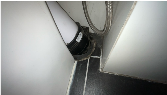
Åpning rundt toalettavløpet.
