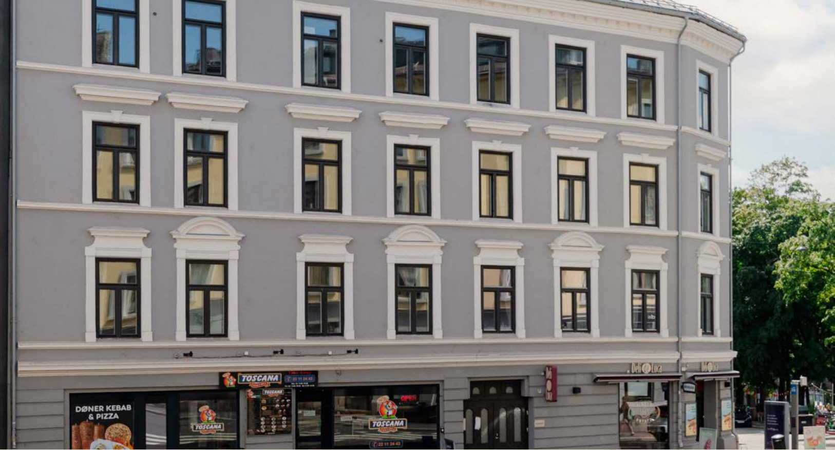
Bygården har en flott fasade.
