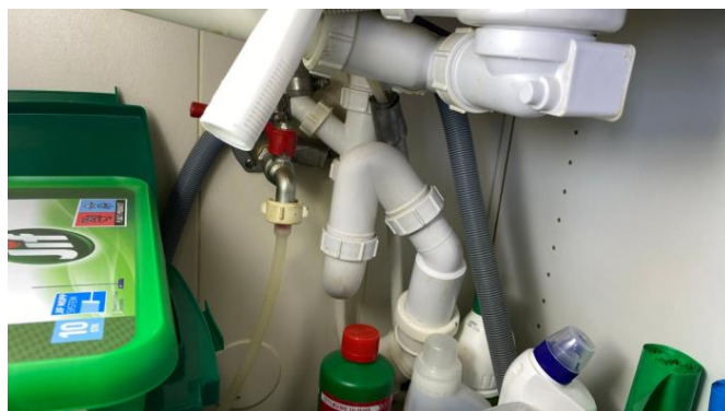
Kontroll av røropplegg.
