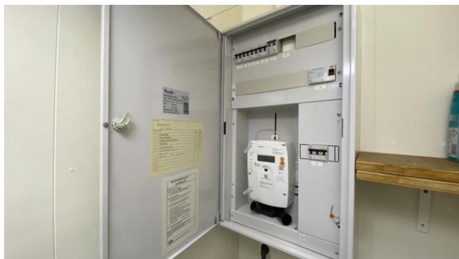
Kontroll av el-skap og kursfortegnelse.
