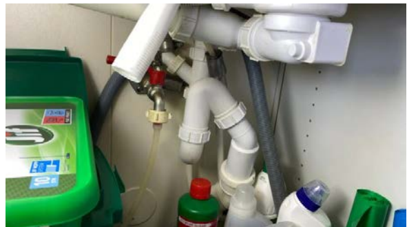
Kontroll av røropplegg.
