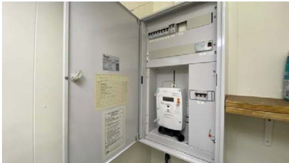
Kontroll av el-skap og kursfortegnelse.
