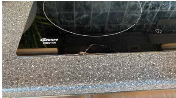
Sprekker i platetopp.
