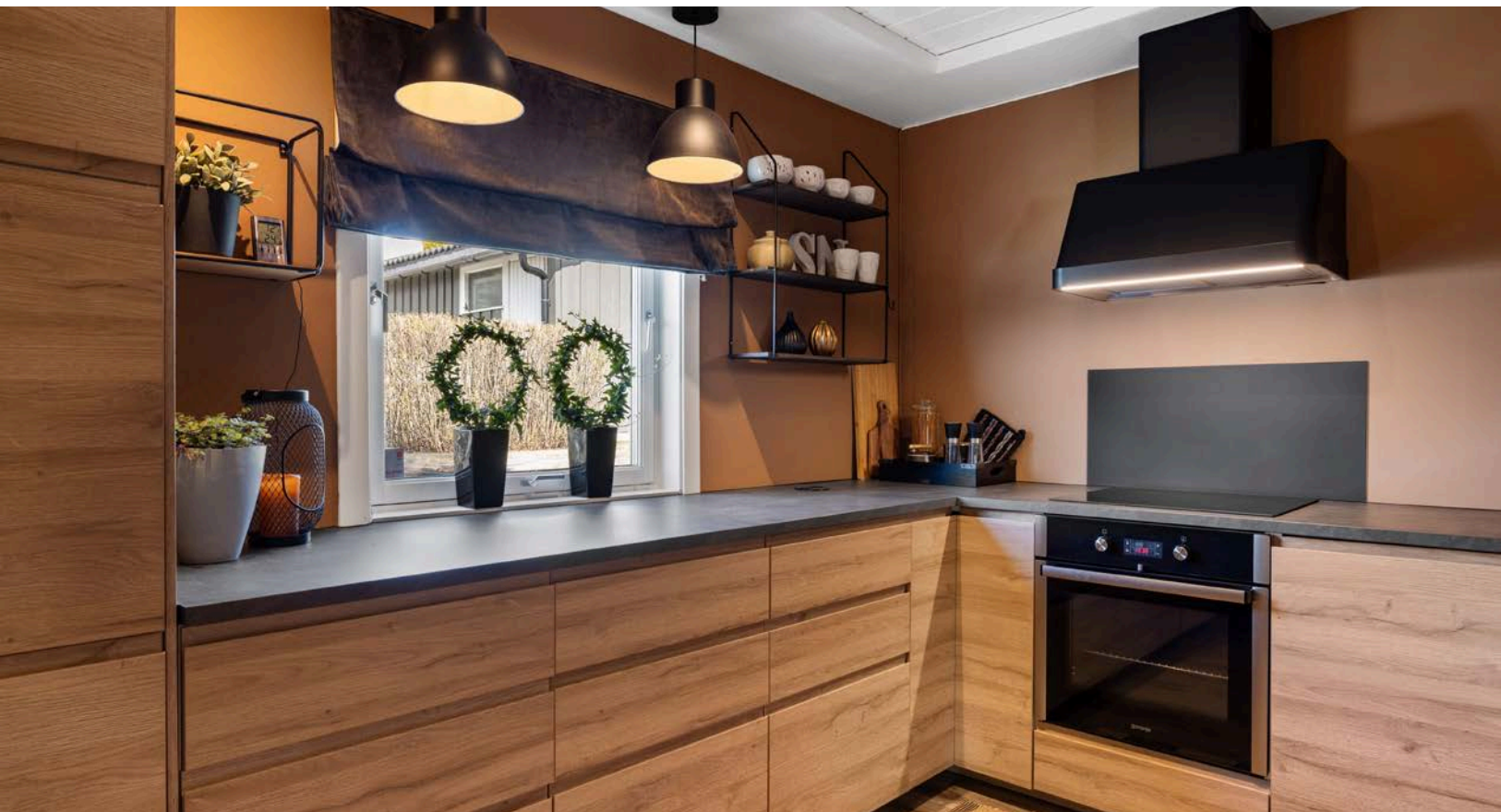
Laminerte benkeplater med oppvaskkum i rustfritt stål. I benkeryggen bak oppvaskkum og platetopp er det påsatt plate for å beskytte vegg for sprut og søl.
