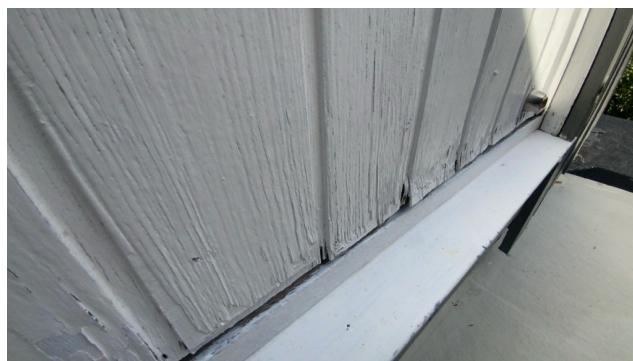
Råteskader.
