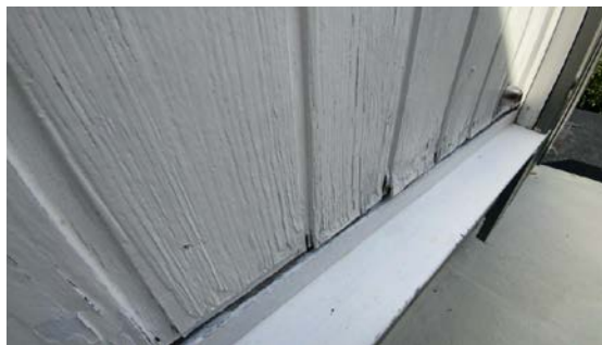
Råteskader.
