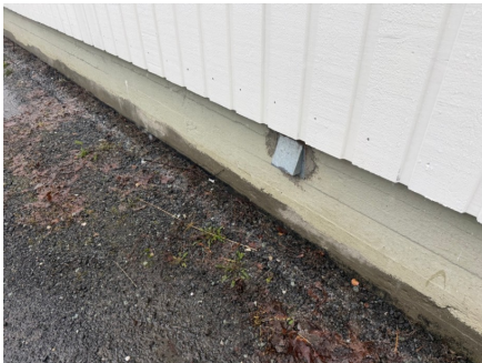
Ingen tegn til grunnmursplast mot vest.
