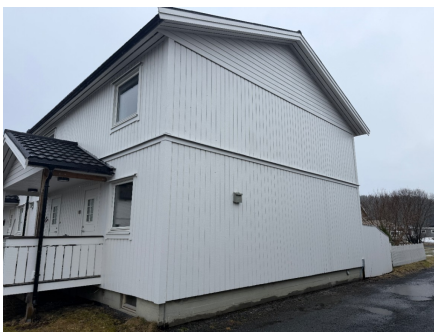
Det er ingen eller liten lufting i nedre kant av kledning mot grunnmur.
