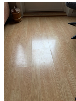
En del bruksmerker på laminatgulv.
