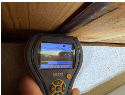
Fuktmåling i tro ved pipe. Tørt.
