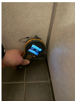
Platene er mangelfullt fuget i nedre del mot aluminiumslisten.
