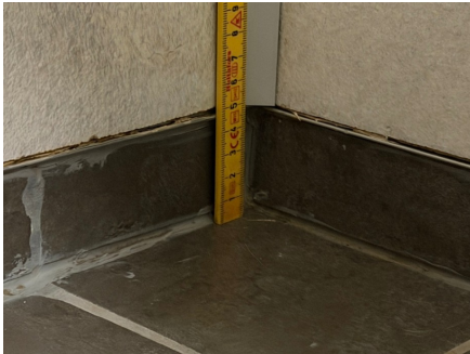
Platene er mangelfullt fuget i nedre del mot aluminiumslisten.
