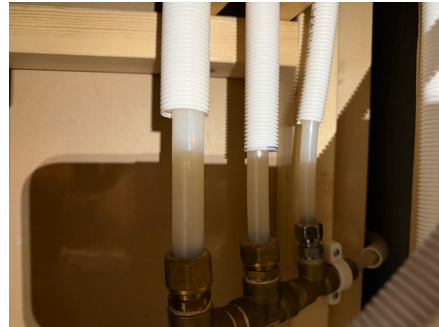
Mangler tettemuffer/skap
