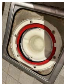
Synlig mansjett under klemring.
