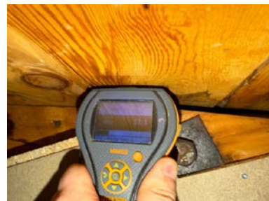
Fuktmåling i tro mot vest (mot raft). Tørt.
