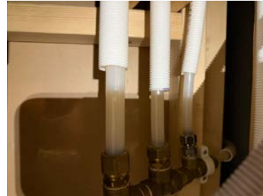
Mangler tettemuffer/skap
