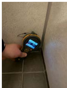
Platene er mangelfullt fuget i nedre del mot aluminiumslisten.
