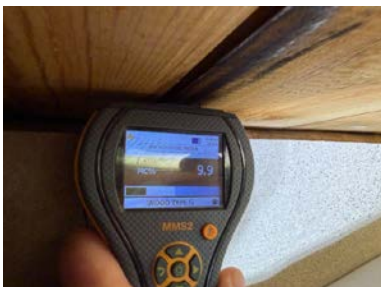
Fuktmåling i tro ved pipe. Tørt.
