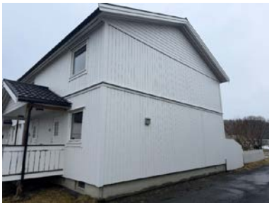
Det er ingen eller liten lufting i nedre kant av kledning mot grunnmur.
