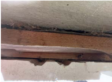
Det er ingen eller liten lufting i nedre kant av kledning mot grunnmur.
