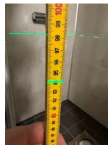
Flis inni dusjhjørne 94,3cm. Motfall til sluk på 4mm.
