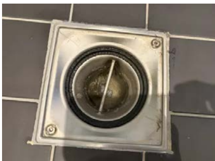
Sluket er et ståtsluk og ingen tegn på skader blir registrert.
