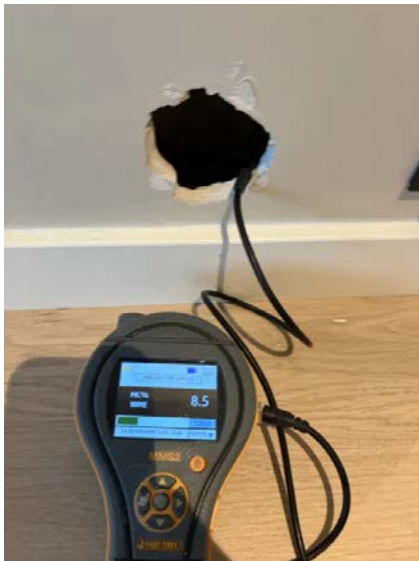
Undersøkelsen på tilstøtende vegg til bad viser ingen tegn til skader eller fukt i konstruksjonen.
