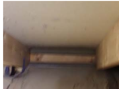
Det er etablert tilstrekkelig lufting av konstruksjonen ved raft
