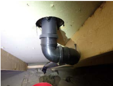
Ingen symptomer på lekkasjer ved gjennomføringer i taket.
