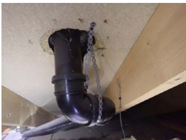
Ingen symptomer på lekkasjer rundt gjennomføringer i taket.
