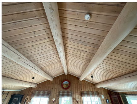
Takkonstruksjon i eldste del av hytta.
