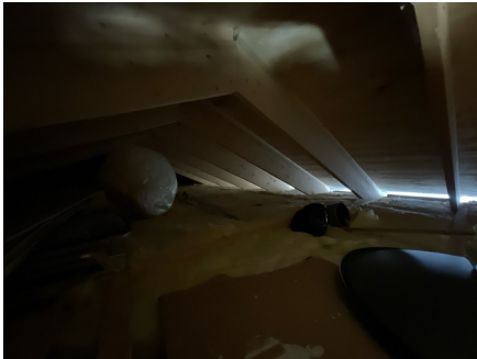
Kaldloft over tilbygg
