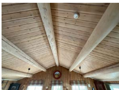
Takkonstruksjon i eldste del av hytta.
