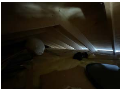
Kaldloft over tilbygg
