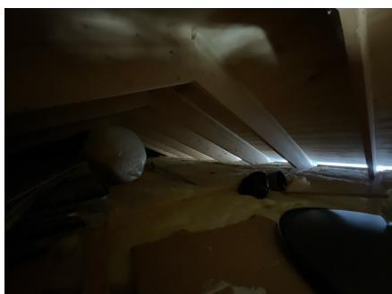
Kaldloft over tilbygg
