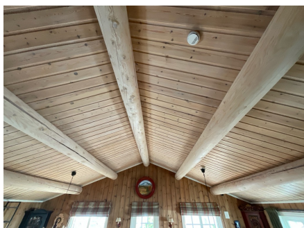
Takkonstruksjon i eldste del av hytta.
