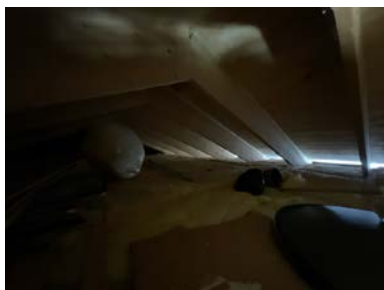
Kaldloft over tilbygg
