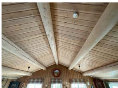
Takkonstruksjon i eldste del av hytta.
