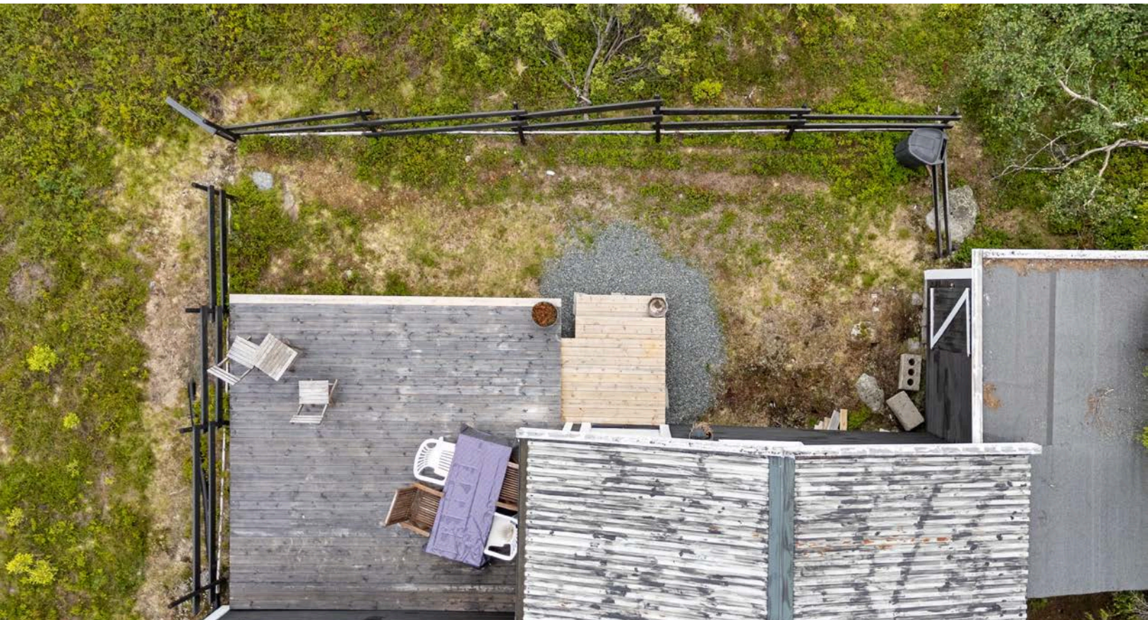
Det er i dag satt opp et gjerde utenfor terrassen. Det er ukjent om dette er godkjent av bortfester. Med skriftlig samtykke fra Pihl kan det aksepteres en mindre innhegning som framstår som en del av bygningsmassen.
