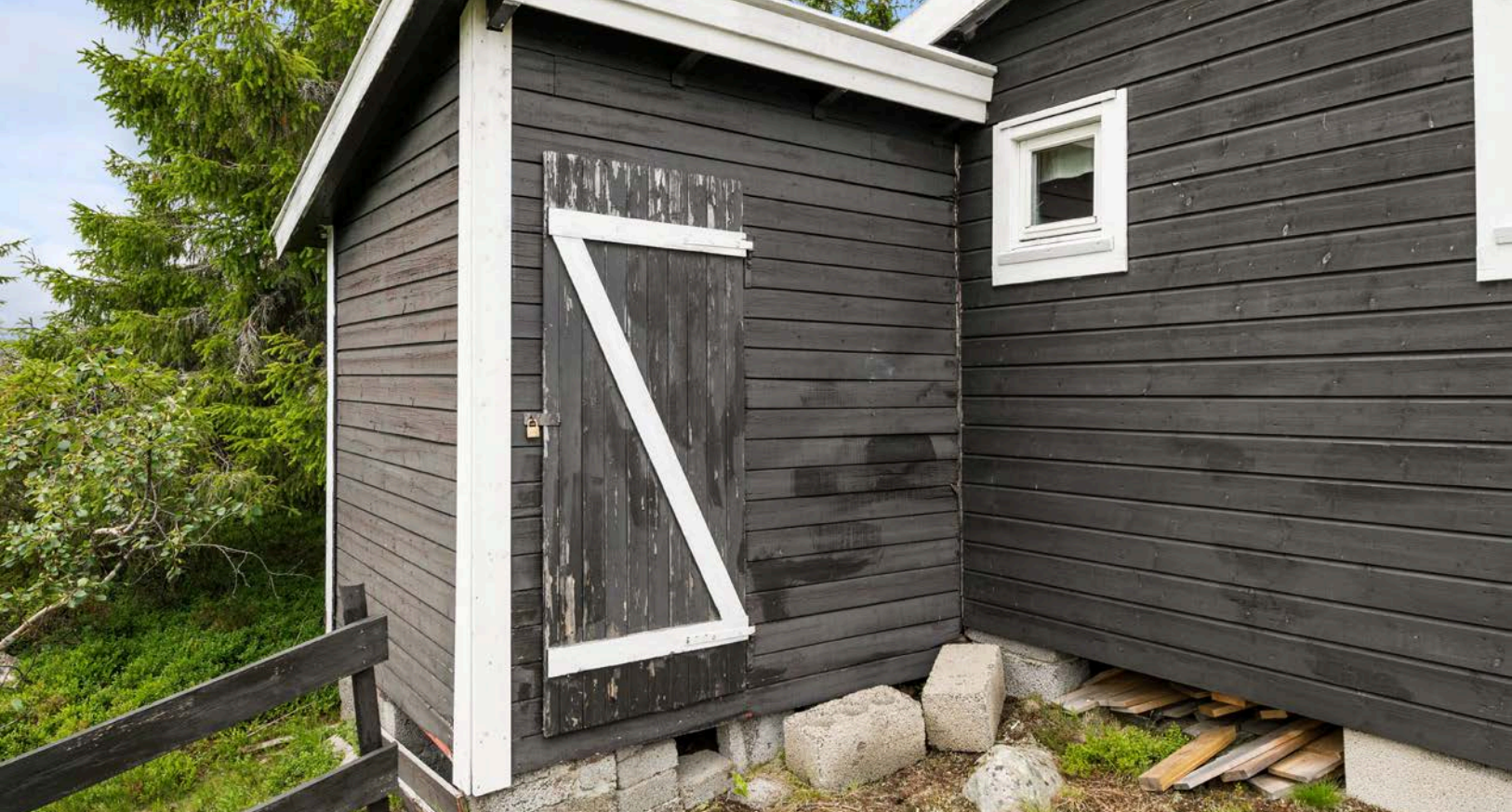
Ved inngangspartiet er det adgang til en utvendig bod på ca. 7m 2 .
