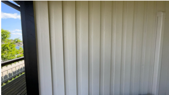
Del av vegg.
