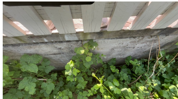
Del av forstøtningsmur.
