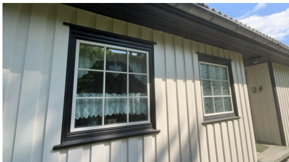
Eksempel på vindu i yttervegg.
