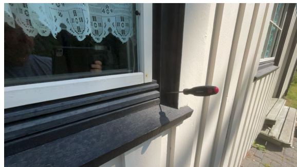
Stikk kontroll på vinduer er utført.
