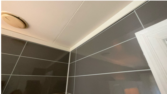
Del av vegg - tak.
