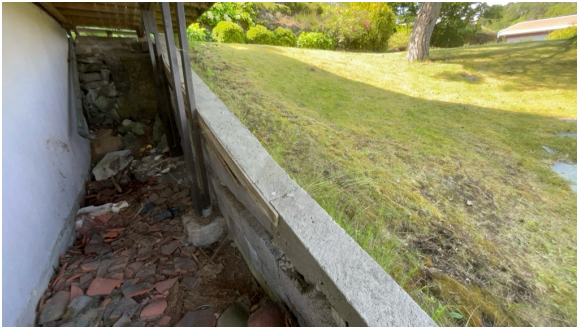
Del av forstøtningsmur.
