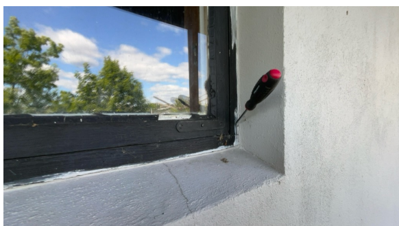
Stikk kontroll på vinduer er utført.
