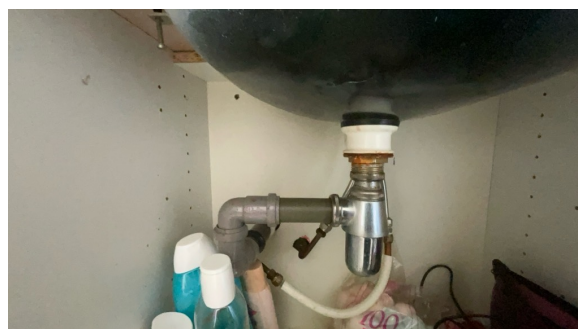
Del av rør til avløp.
