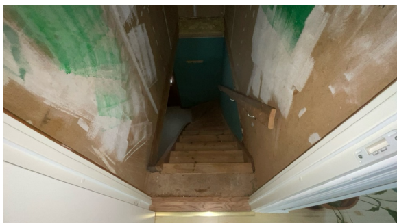
Trapp ned til underetasjen.
