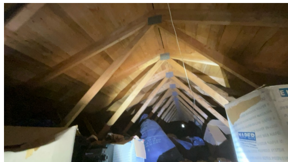
Del av takkonstruksjon, sett fra loft.
