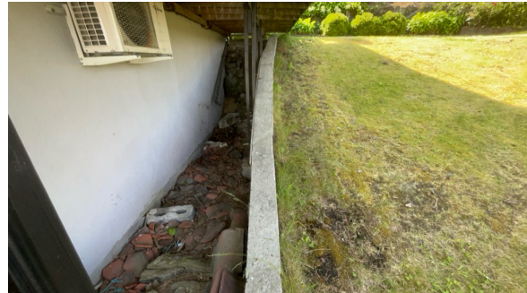
Del av forstøtningsmur.
