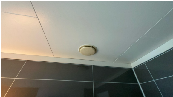
Montert ventil i tak.
