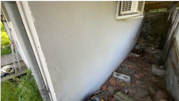
Del av grunnmur.
