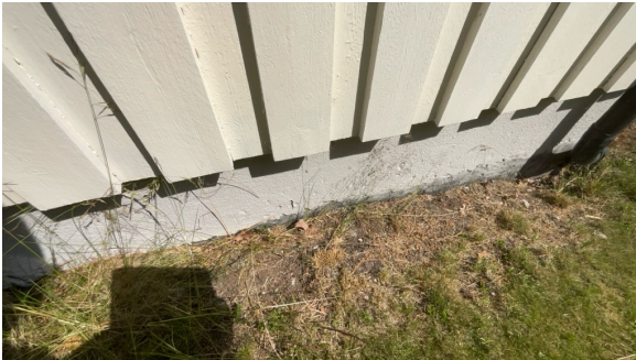
Del av grunnmur.
