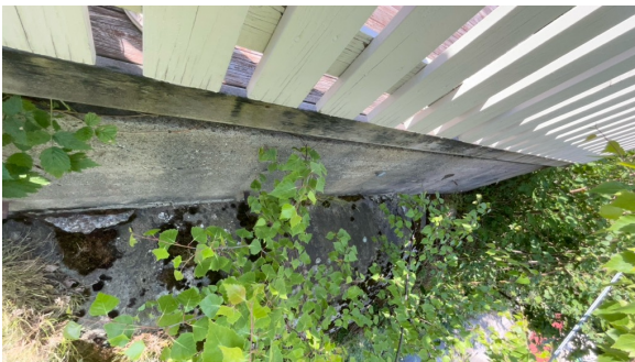
Del av forstøtningsmur.
