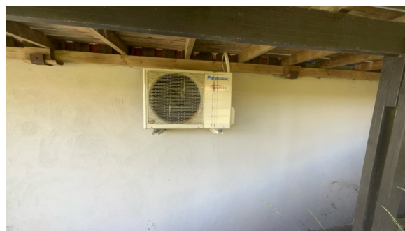
Varmepumpe ytterdel.
