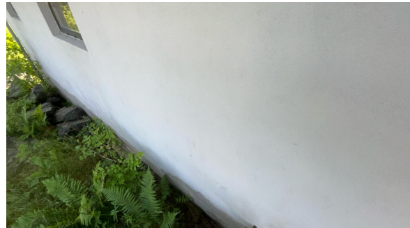
Del av grunnmur.
