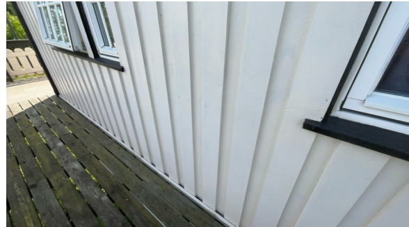
Del av vegg.
