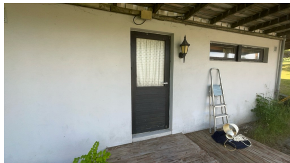
Dør inn til underetasjen.
