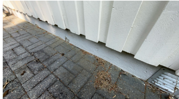
Del av grunnmur.
