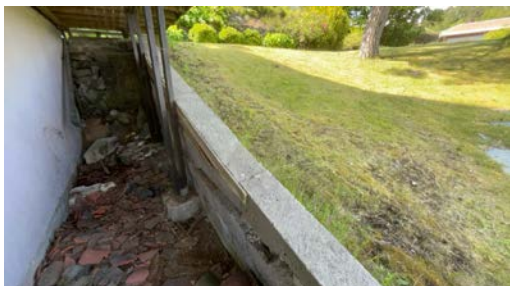
Del av forstøtningsmur.
