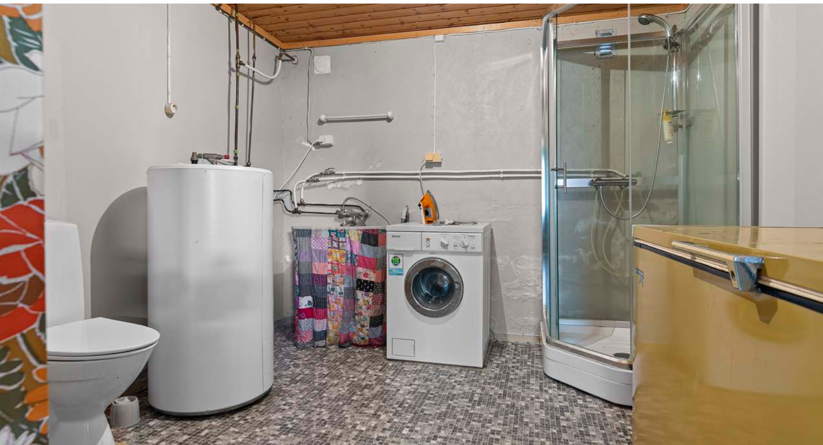
Bad/vaskerom i underetasjen som inneholder toalett, dusjkabinett og opplegg til vaskemaskin. Her står i tillegg varmtvannstanken.
