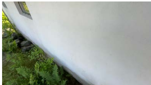
Del av grunnmur.
