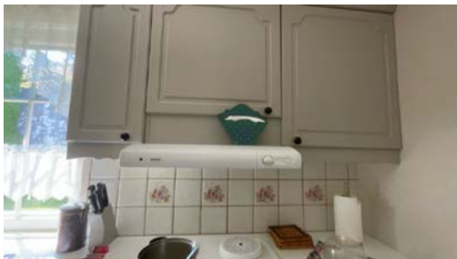
Montert avtrekk over steketopp.
