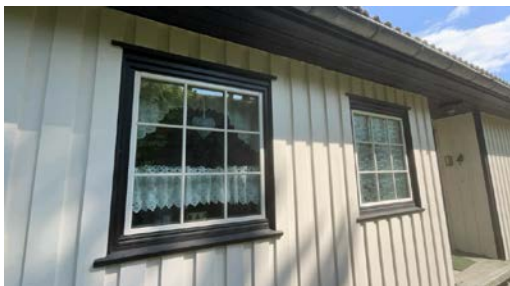
Eksempel på vindu i yttervegg.
