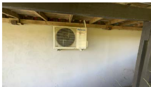
Varmepumpe ytterdel.
