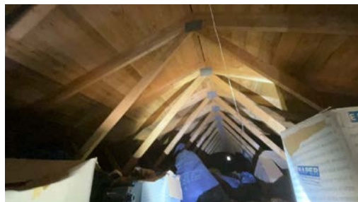
Del av takkonstruksjon, sett fra loft.
