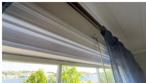
Eksempel på montert ventil i vindu.
