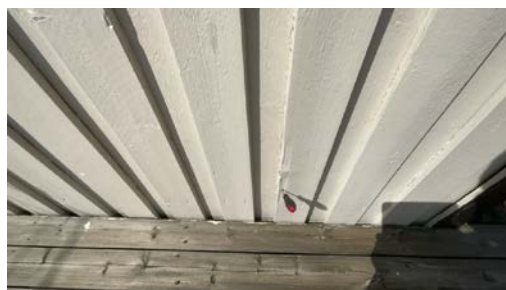
Stikk kontroll av vegger er utført.
