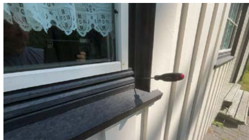
Stikk kontroll på vinduer er utført.
