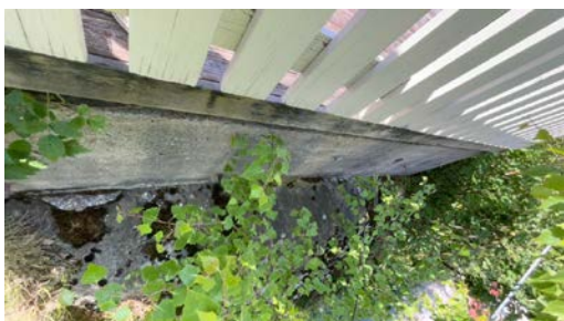
Del av forstøtningsmur.
