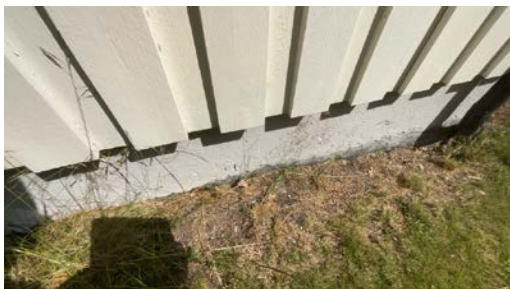
Del av grunnmur.
