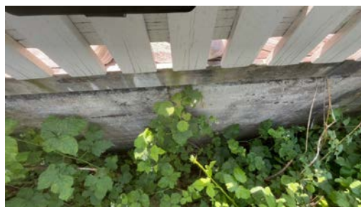
Del av forstøtningsmur.
