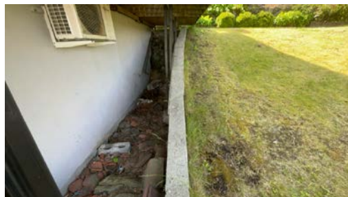
Del av forstøtningsmur.
