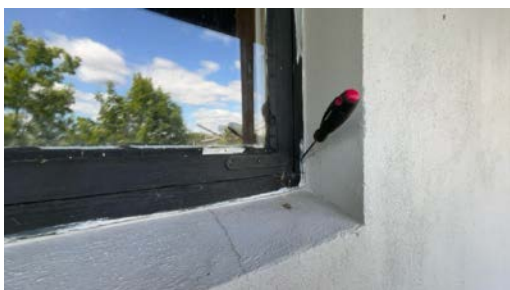
Stikk kontroll på vinduer er utført.
