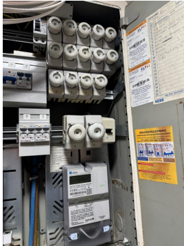
Sikringskap med automat/skrusikringer.
