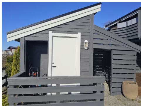
Frittstående utebod med vedskjul.
