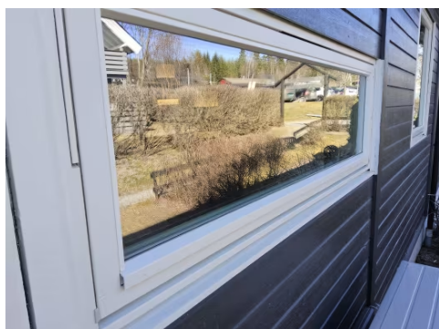
Boligen har nyere vinduer og dører.
