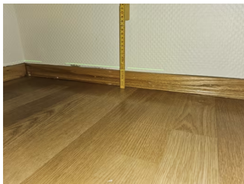
Etasjeskiller er kontrollert med nivelleringslaser.
