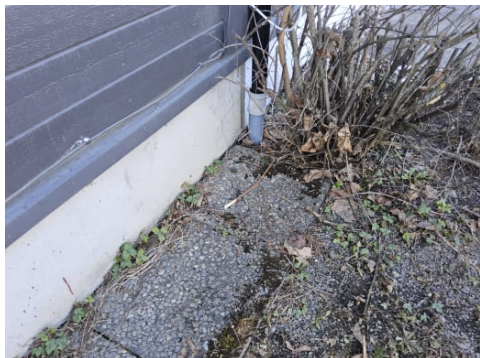
Taknedløp er ført ned i lukket rør.
