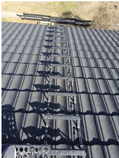
Det er etablert takstige til pipe.
