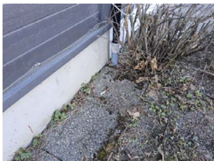
Taknedløp er ført ned i lukket rør.
