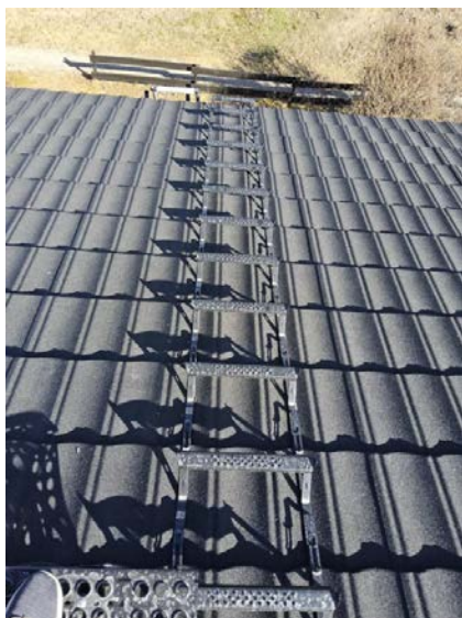
Det er etablert takstige til pipe.
