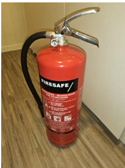
Boligen har godkjent brannslukningsapparat.
