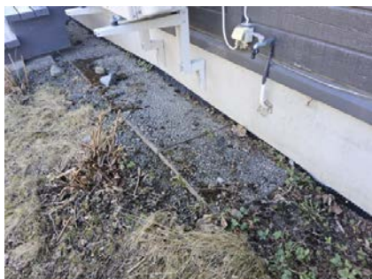
Grunnmur av betong.
