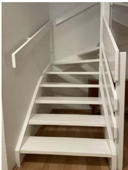
Åpen trapp av tre mellom etasjene.
