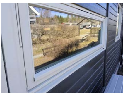
Boligen har nyere vinduer og dører.
