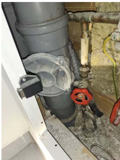
Stakeluke er tilgjengelig via inspeksjonsluke på toalettrom.
