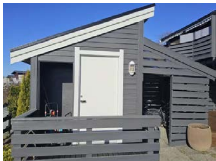
Frittstående utebod med vedskjul.
