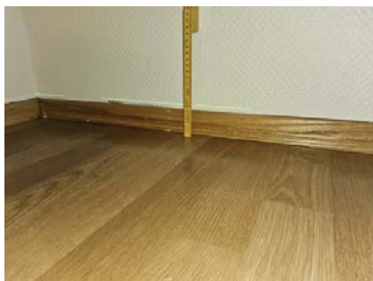
Etasjeskiller er kontrollert med nivelleringslaser.
