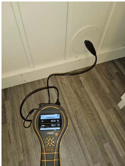
Bilde fra fuktmåling i utlektet veggkonstruksjon.
