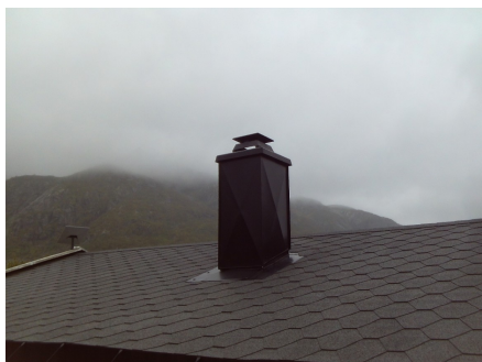
Deler av tekkingen med takgjennomføring
