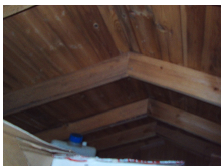
Deler av takkonstruksjonen.
