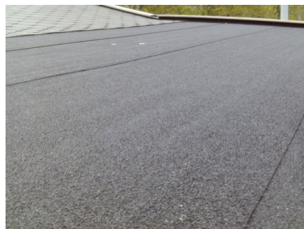
Ny tekking over tilbygget del.
