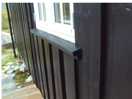
Deler av kledningen med tilhørende belistninger.
