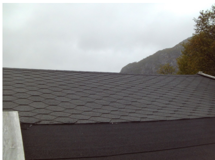
Overgang i mellom opprinnlig og tilbygget del.
