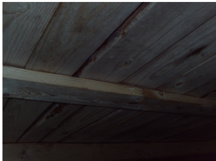
Underliggende stubbloft av bord.
