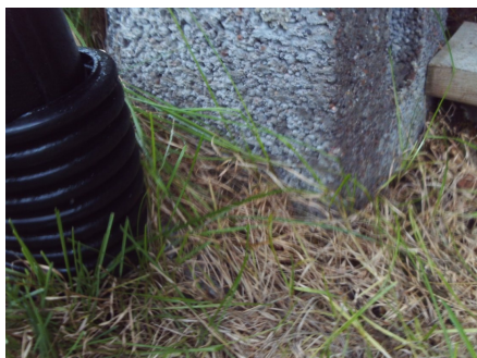
Ligger jordmasser inntil mpilarer av leca.
