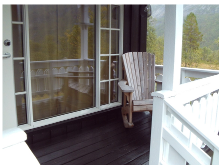
Eldre terrasse som er overbygget ved inngangsparti.
