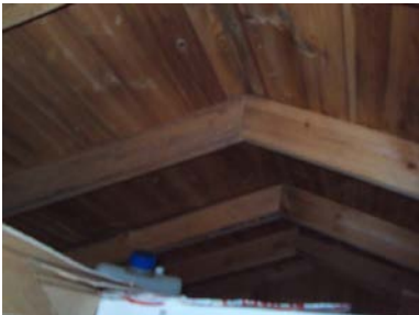
Deler av takkonstruksjonen.
