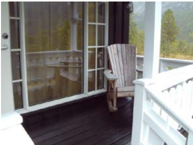
Eldre terrasse som er overbygget ved inngangsparti.
