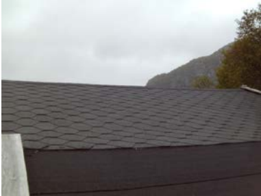
Overgang i mellom opprinnlig og tilbygget del.
