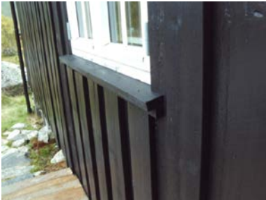
Deler av kledningen med tilhørende belistninger.
