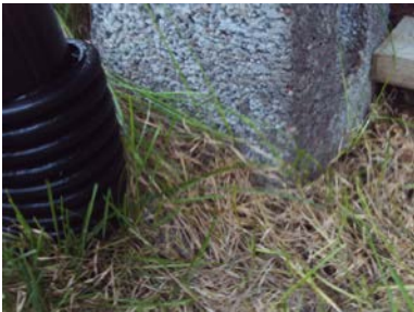
Ligger jordmasser inntil mpilarer av leca.
