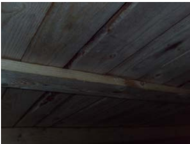
Underliggende stubbloft av bord.
