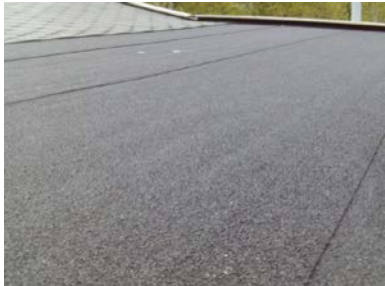
Ny tekking over tilbygget del.
