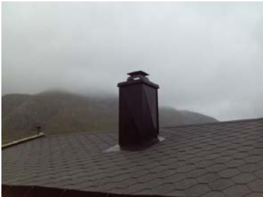
Deler av tekkingen med taggjennomføring
