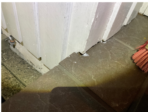
Stående trepanel mot flislagt trapp
