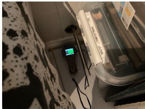
Hulltaking i yttervegg rom under terreng 18. mars 2026
