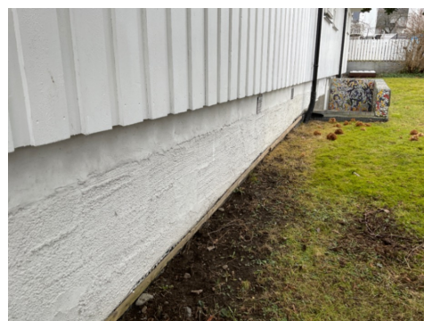
Grunnmur på baksiden av huset
