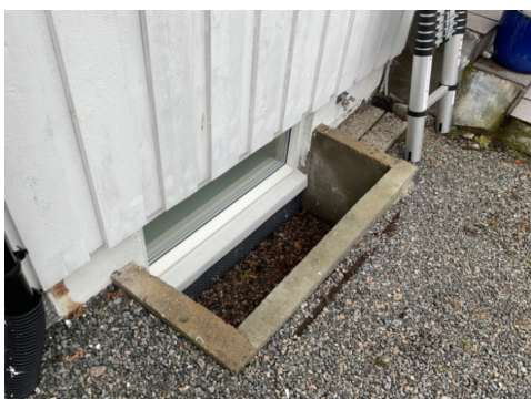
Lysgrav til boden i kjelleren
