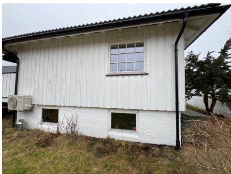
Kjeller og kjøkkenvindu
