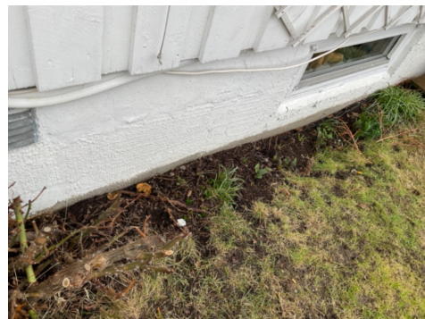
Knotteplast under og over terreng, mellom inngangsparti og terrasse
