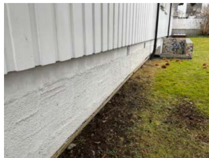
Grunnmur på baksiden av huset
