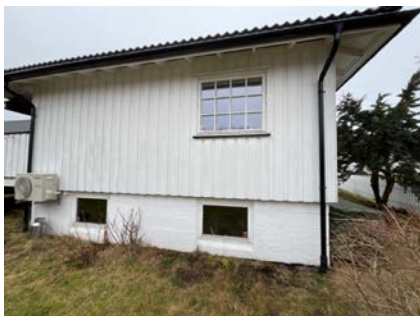
Kjeller og kjøkkenvindu
