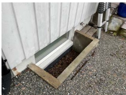
Lysgrav til boden i kjelleren
