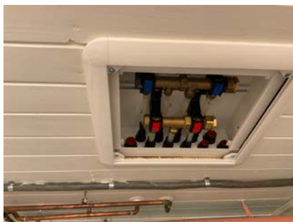
Rør i rørskap til baderomskap er montert i taket i teknisk rom
