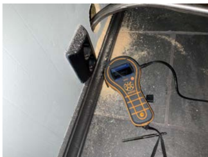
Hulltaking i kjellerstue mot baderom 18. Mars 2026
