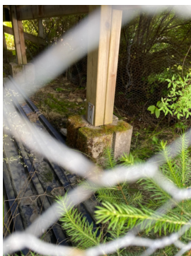
Fundamentert på søyler på betongfundamenter på mark,
