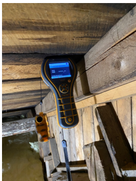
Fuktmåling i takkonstruksjon viste ingen forhøyede fuktverdier. (takkonstruksjon mot sør.)
