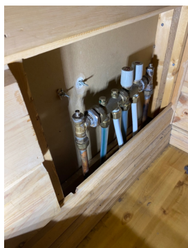
Luke i vegg mot badet i hovedetasjen med fordeling for vannbåren varme.
