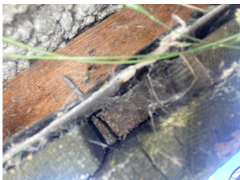
Begrenset lufting bak kledning.
