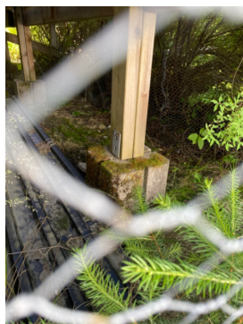
Fundamentert på søyler på betongfundamenter på mark,
