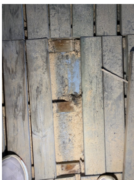
Steinplater el. på oversiden av bjelkelag over carport
