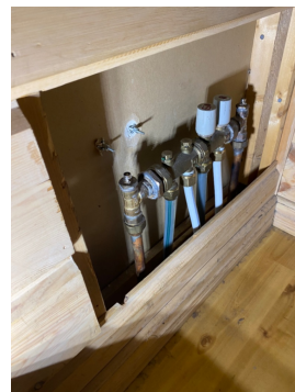
Luke i vegg mot badet i hovedetasjen med fordeling for vannbåren varme.
