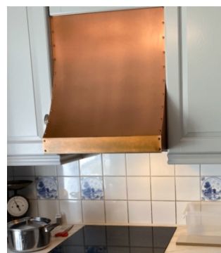
Ventilator kledd med kobber.
