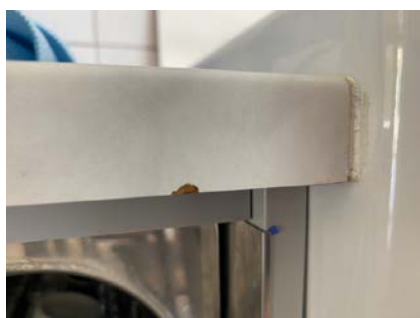
Skade i benkeplate.
