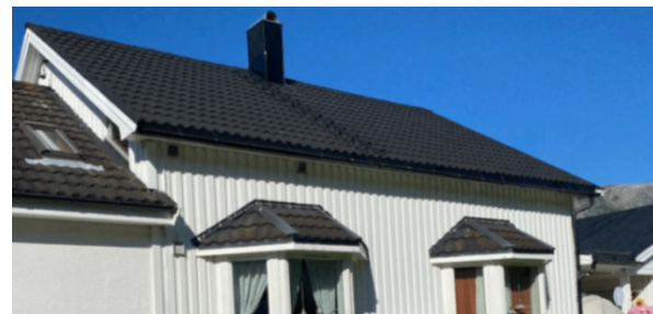
Tak mot øst
