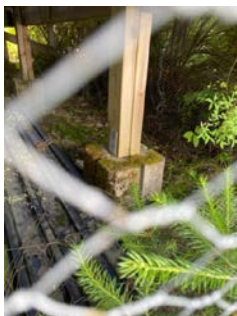
Fundamentert på søyler på betongfundamenter på mark,
