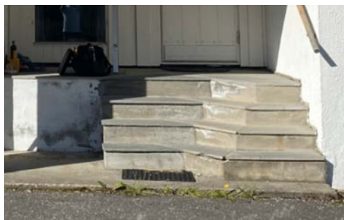
Betongtrapp med skiferstein.
