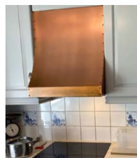
Ventilator kledd med kobber.
