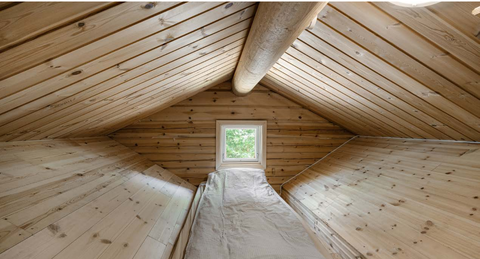
Det er vindu i den ene gavlveggen på loftet.
