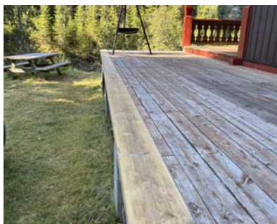
Manglende rekkverk.
