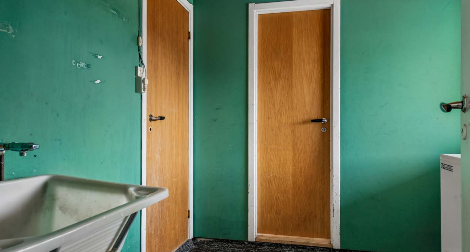
Eldre vaskerom med belegg og sluk i gulv.
