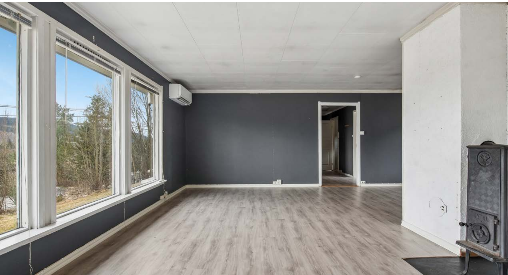
I stuen er også en luft-til-luft varmepumpe.
