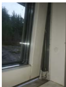
Nytt vindu på bad. Unøydaktig listing. 3 lags glass.
