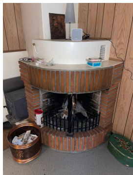
Mangler ubrennbar plate på gulv foran peis
