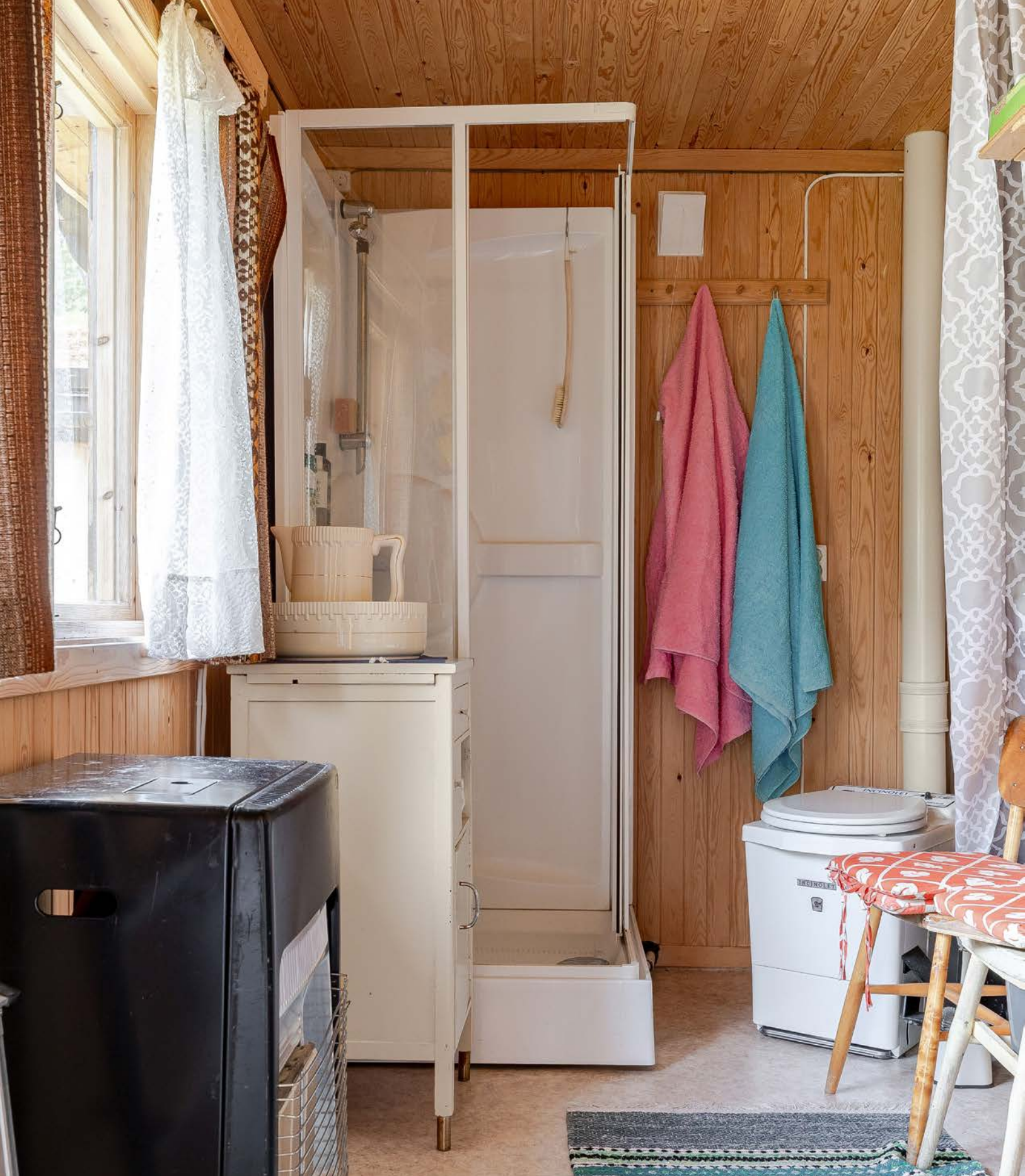
Bod i annekset innredet som hygienerom (ikke godkjent for varig opphold). Rommet er utstyrt med forbrenningsdo og dusjkabinett.
