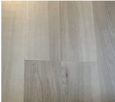
Fuktsvelling og skjøter ligger ikke i forband.
