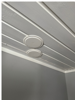
Fuktsvelling og skjøter ligger ikke i forband.
