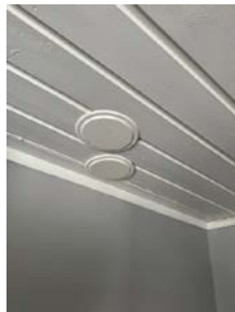
Fuktsvelling og skjøter ligger ikke i forband.
