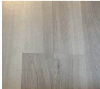
Fuktsvelling og skjøter ligger ikke i forband.
