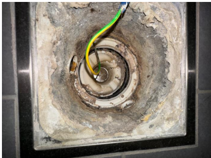
Plastsluk med klemring under servant (hovedsluk)
