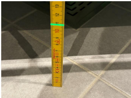
Fallforhold ca. 108 mm overkant gulv foran servant
