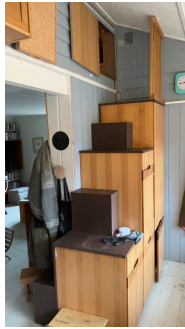
Trapp til loft bygget over kjøkkeninnredning
