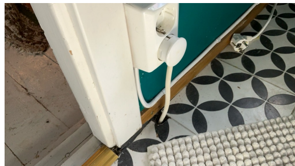
Varmtvannsbereider er tilkoblet via stikkontakt på badet.
