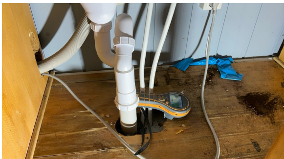
Ingen fuktindikasjoner registrert ved fuktsøk
