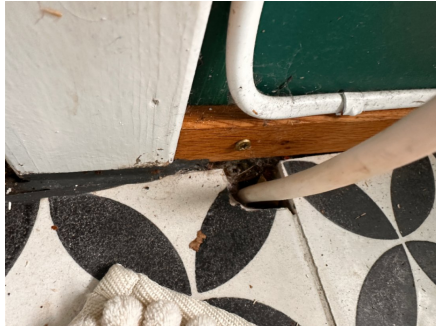
Hull i badegulv for strømlledning til bereder
