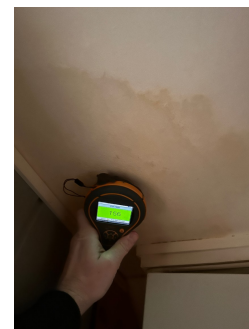
Ingen fuktindikasjoner registrert ved fuktsøk
