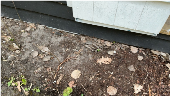
Kledning med liten klaring til terreng.
