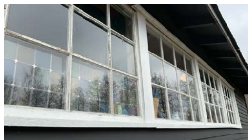
Vinduer til kjøkken og bad
