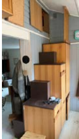
Trapp til loft bygget over kjøkkeninnredning
