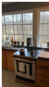
Mangler mekanisk avtrekk til kokesonen
