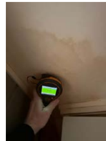
Ingen fuktindikasjoner registrert ved fuktsøk
