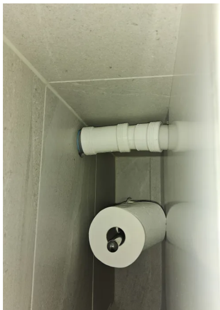
Bilde viser avløpsrør på toalettrom.
