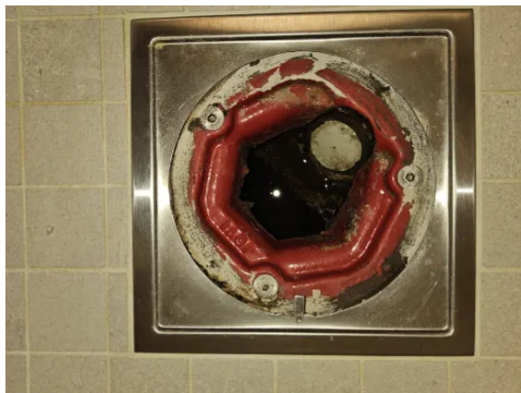
Bilde viser sluk på bad.
