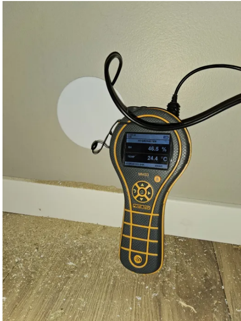
Bilde viser fuktmåling.
