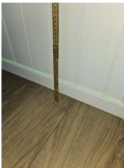
Bilde viser måling etasjeskiller.
