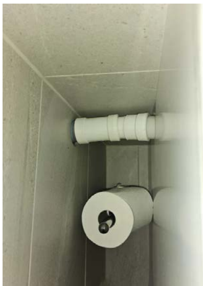
Bilde viser avløpsrør på toalettrom.
