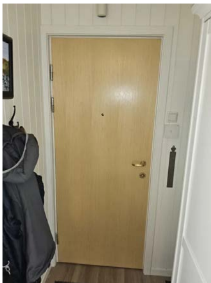
Bilde viser entrédør.
