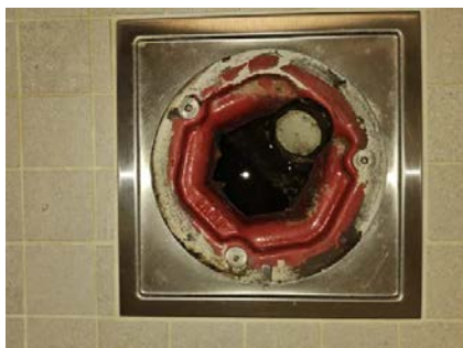
Bilde viser sluk på bad.
