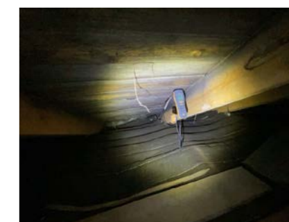
Ikke luftespalter ved raft-litt svertet taktro
