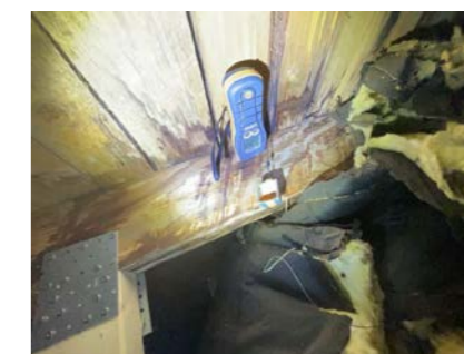
Skjolder ved pipeeksling
