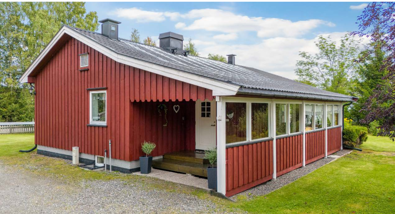
Eneboligen ble tilbygget i 1999 og i den forbindelse ble det lagt ny takteking. Kledningen er sist overflatebehandlet i 2016 med ett strøk.
