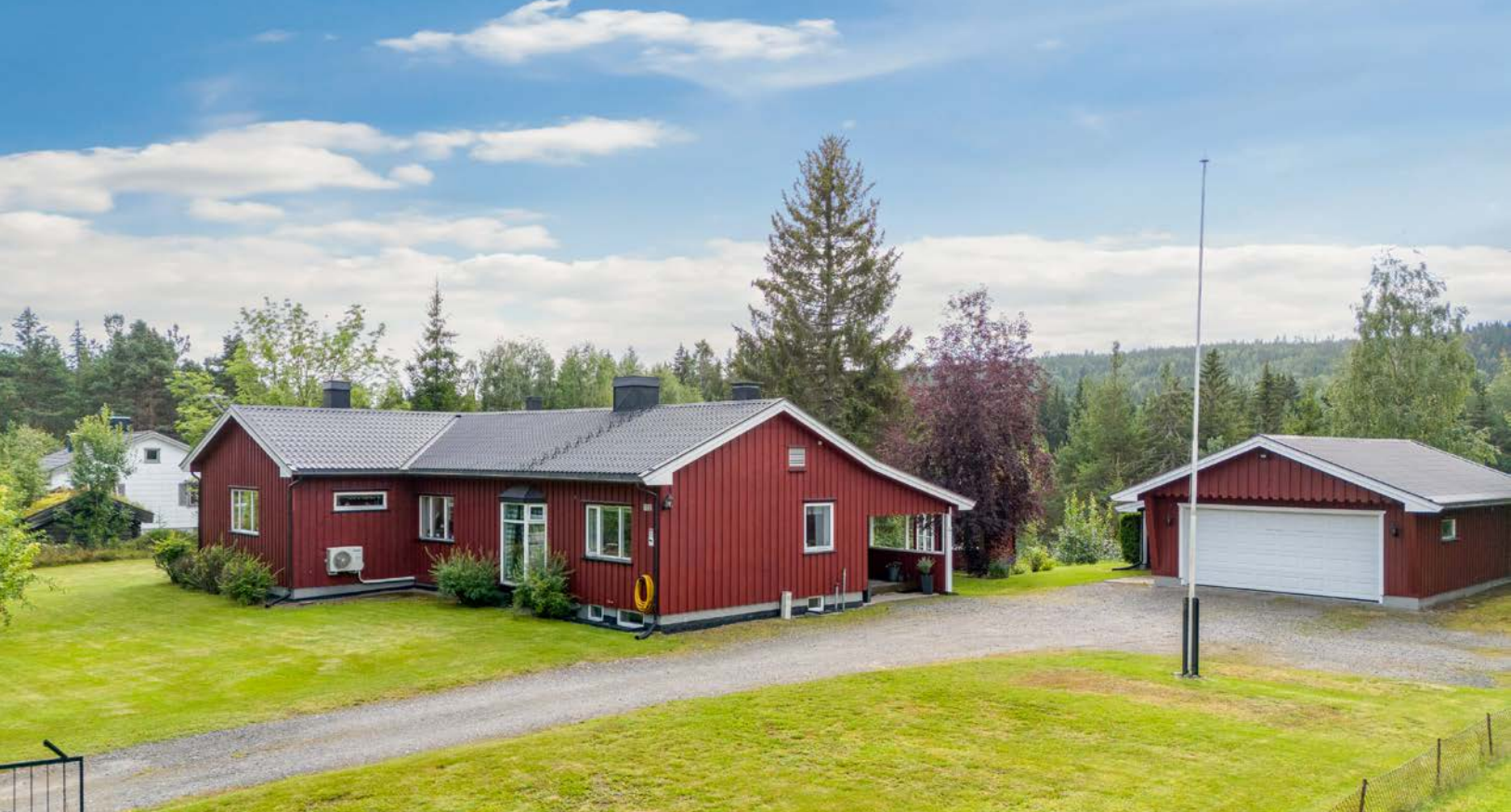
Eiendommen "Glomheim" er bebygd med en enebolig fra 1955 som ble tilbygget i 1999, en garasje fra 1999 og et lysthus fra ca. 2016.
