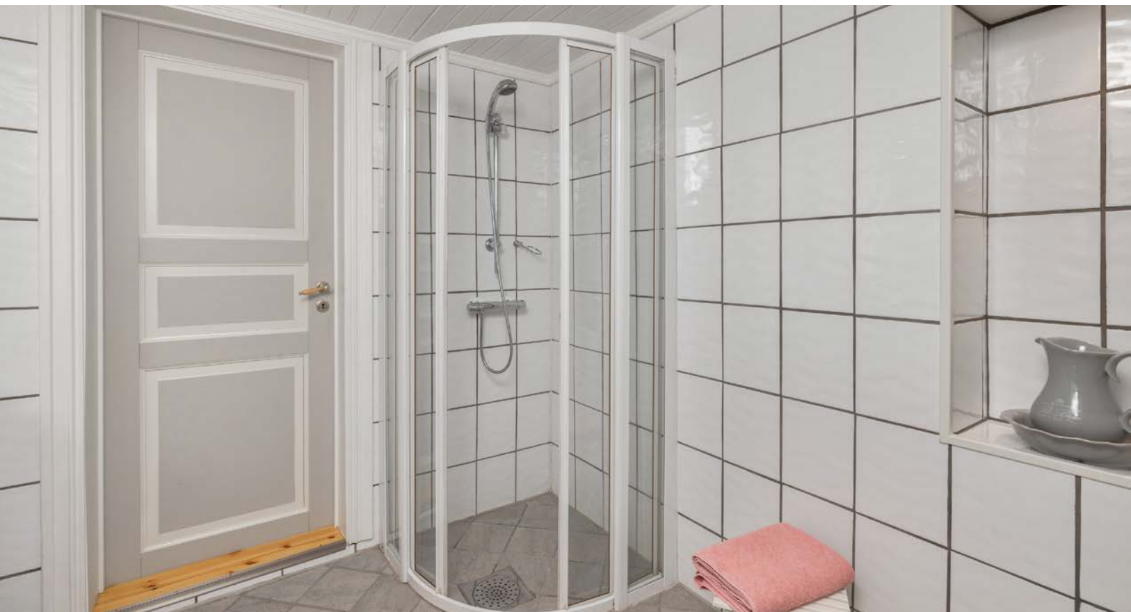
Baderommet har grå fliser på gulv, elektrisk gulvvarme, vegger med hvite fliser kombinert med lysegrå panelplater, samt mekanisk avtrekk.
