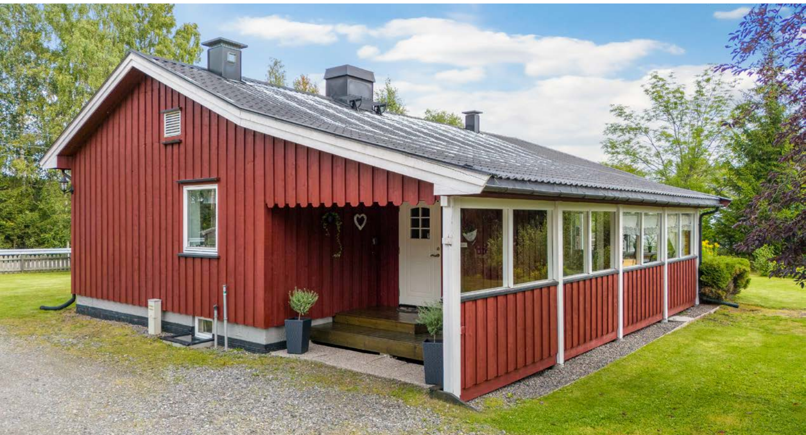
Eneboligen ble tilbygget i 1999 og i den forbindelse ble det lagt ny taktekking. Kledningen er sist overflatebehandlet i 2016 med ett strøk.
