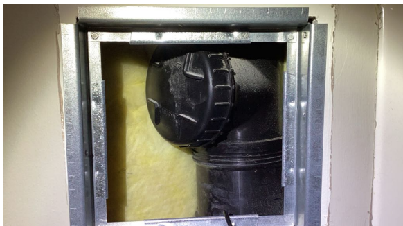
Stakeluke lokalisert i inspeksjonsluke på kontor/soverom.
