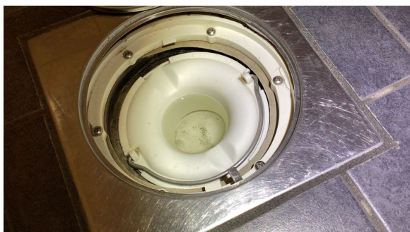
Kontroll av sluk.
