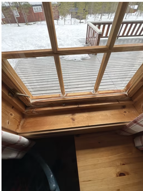
Det registreres misfarging på innvendige karmmer og foringer, trolig pga. kondens.
