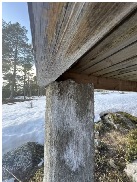
Bjolkene hviler ikke sentrert på fundamenter og ligger delvis utenfor.
