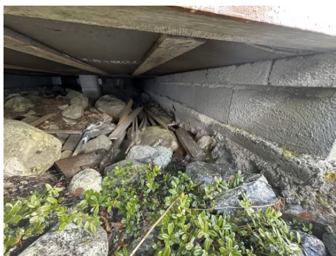
Viser krypkjeller under eldre del.
