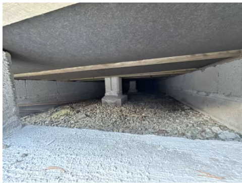
Viser krypkjeller under tilbygg.
