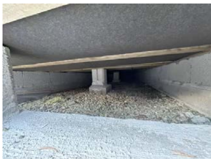
Viser krypkjeller under tilbygg.
