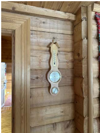
Det registreres fuktskjolder på maskinlaft.
