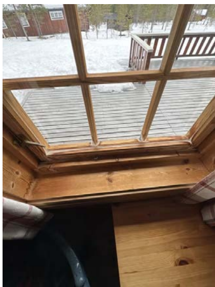
Det registreres misfarging på innvendige karmen og foringer, trolig pga. kondens.
