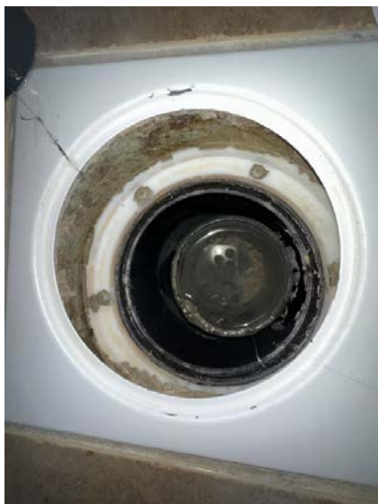
Viser sluk i dusjsonen.
