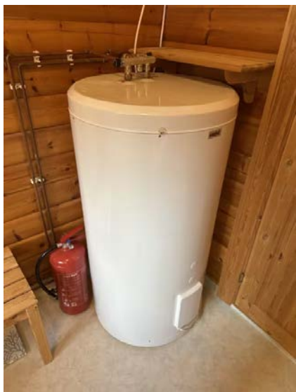
Viser bereder plasser på bad.
