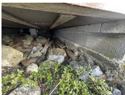
Viser krypkjeller under eldre del.
