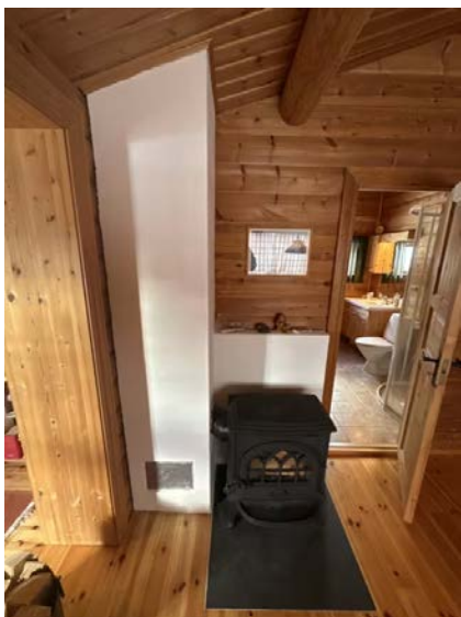
Viser vedovn og søtluke i stue tilbygg.
