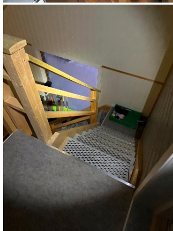
Trapperom til 2 etasje
