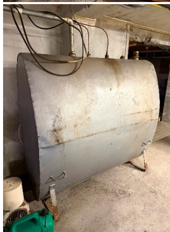
Oljetank i kjeller
