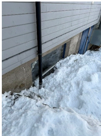
Vindu er nært bakken
