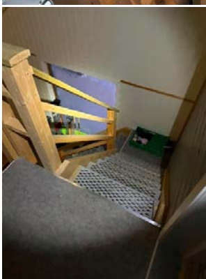
Trapperom til 2 etasje
